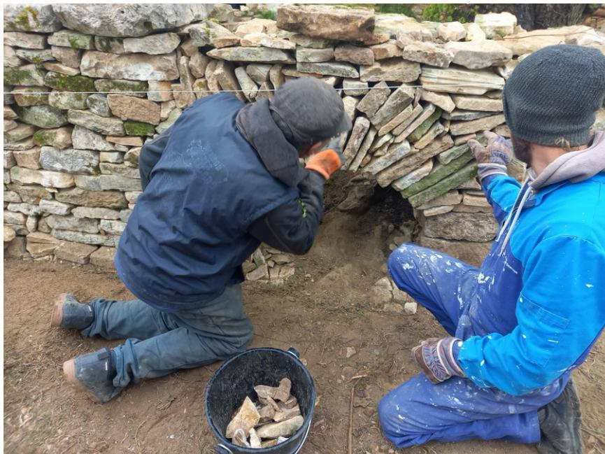
La phase la plus délicate ! la construction de l'arc de voûte pour laisser passer les racines
