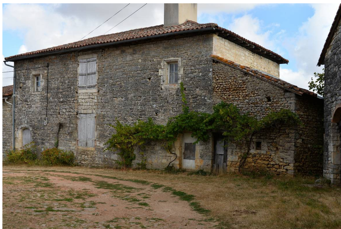
L'armoirie placée au-dessus du linteau de la porte d'entrée pourrait indiquer que ce bâtiment était le logement de la prieure.
