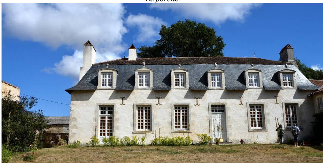
La façade du pavillon, récemment restaurée.
