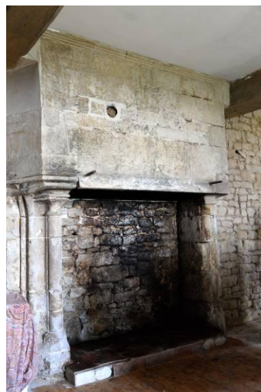
Cheminée dans une des salles.
