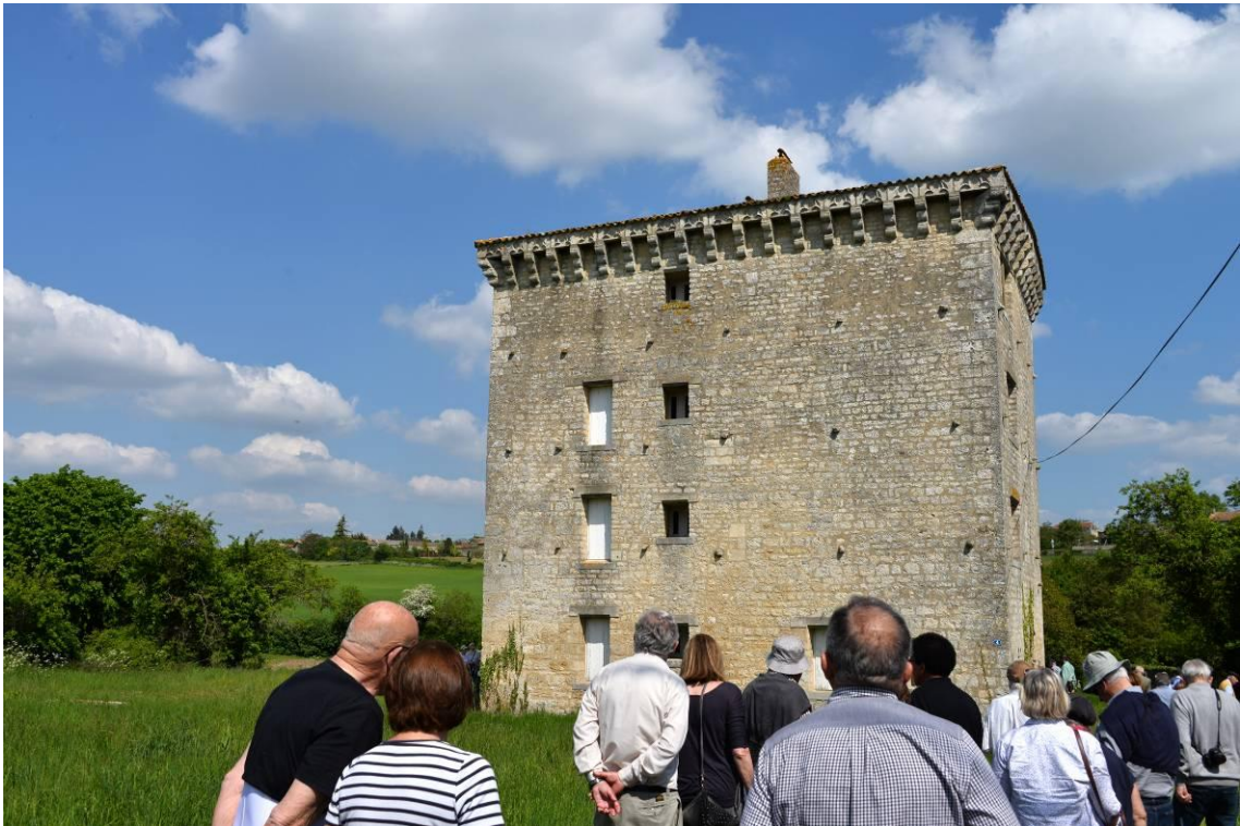
La tour carrée.
