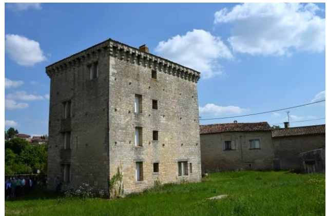
Plusieurs logements avaient été aménagés dans cette tour.
