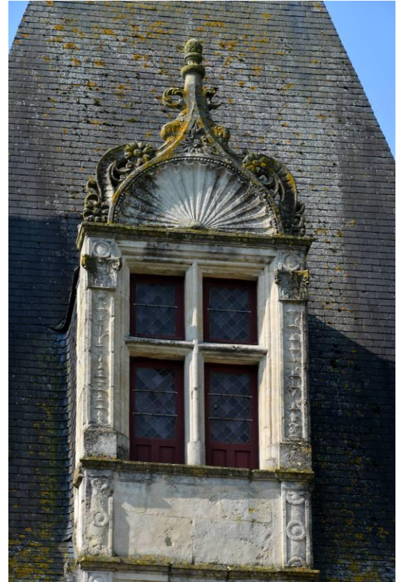
Les fenêtres Renaissance sont très belles
