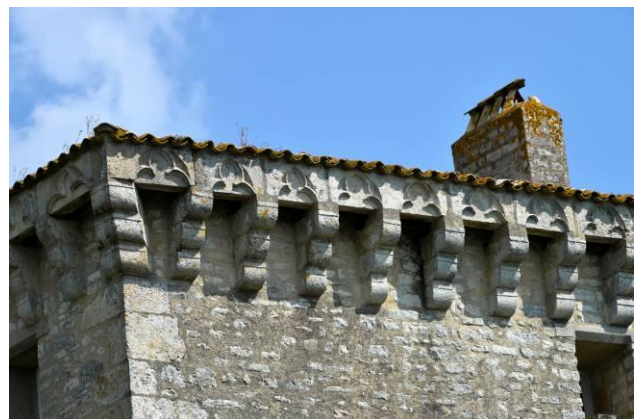
Détail du sommet crénelé de la tour.
