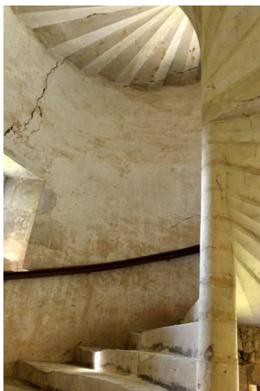
Escalier en vis de la tour.
