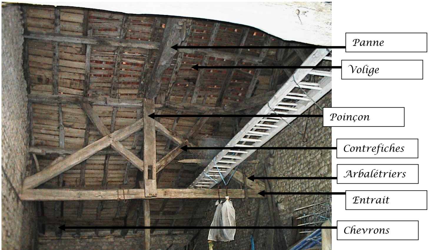
Ferme de charpente traditionnelle.
