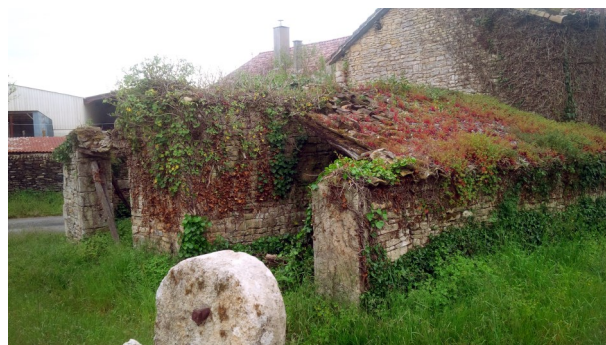
Photo d'ensemble, vue de la cour intérieure.
