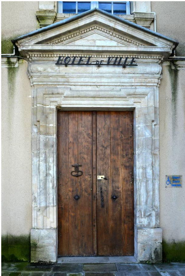
Une des portes de l'Hôtel Pied Foulard. Détails des ferrures : marteau de porte, poignées, Vestige d'un loquet poucier.
