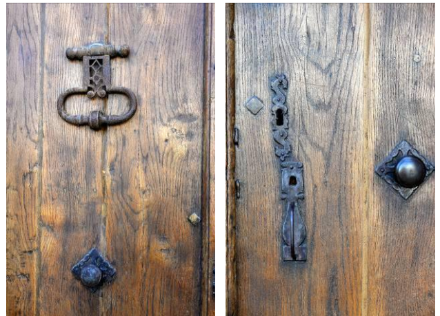
Une des portes de l'Hôtel Pied Foulard. Détails des ferrures : marteau de porte, poignées, Vestige d'un loquet poucier.
