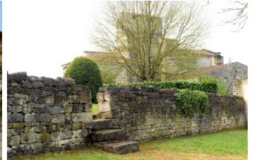
Mur de pierres
