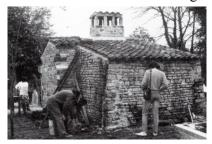
Le cul du four est recouvert de tuiles calées avec du mortier de chaux grasse.
