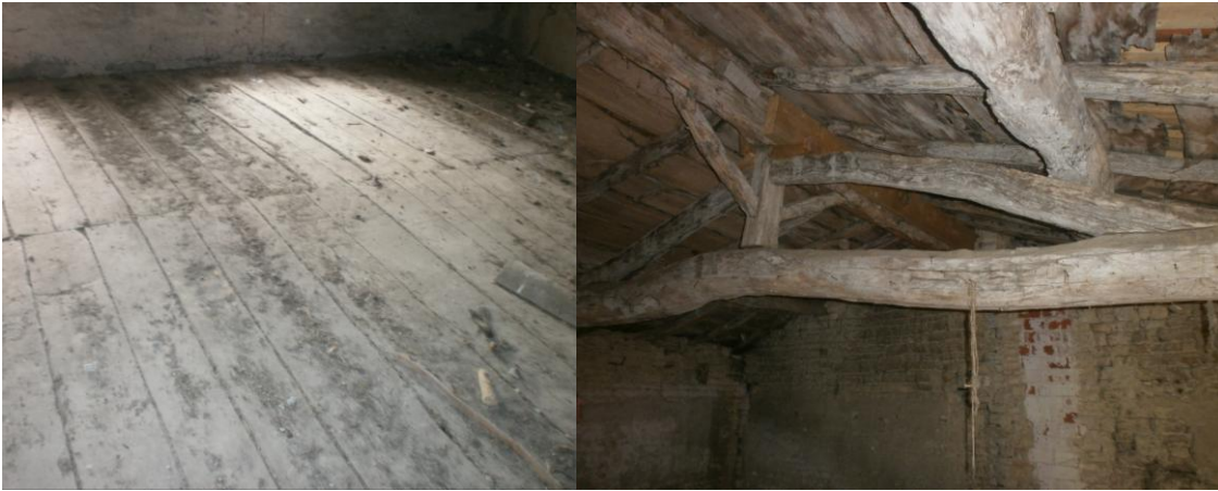
Plancher ancien à lame pleine et de différente largeur. Charpente dont les bois sont simplement dégrossis.
