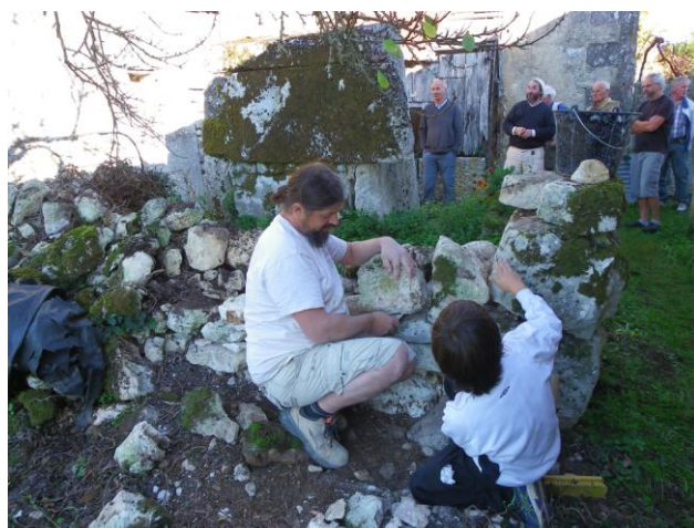
Murets en pierres sèches
