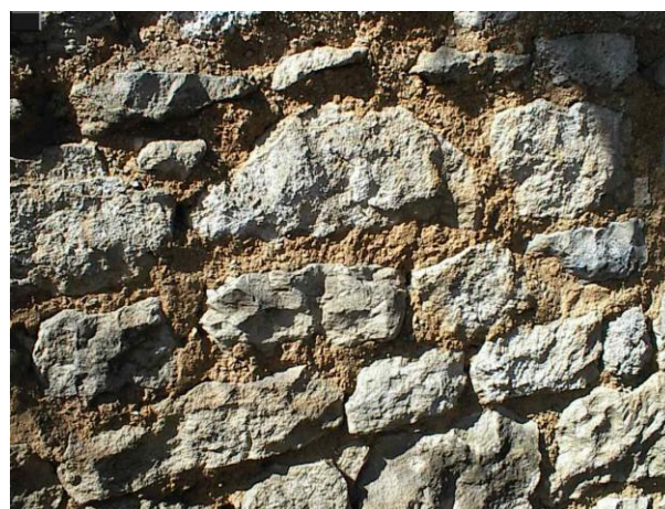
Mur construit avec un mortier de terre argileuse
