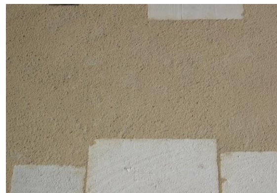
Enduit traditionnel refait à neuf
