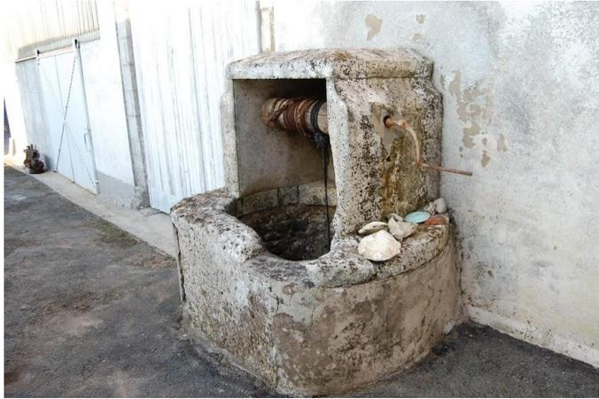
Devia, **Petit puits adossé**: bâti en grandes dalles de pierre (façade avant, jambages, toit) et pierre de taille (margelle). Les côtés arrondis sont en moellons enduits.
