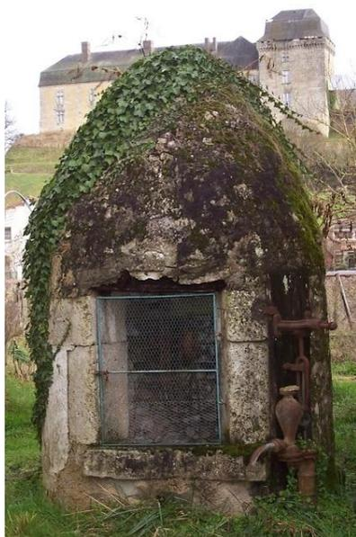
Puits en forme « d'obus » ou puits à Gavache adjoint d'une pompe à eau.
