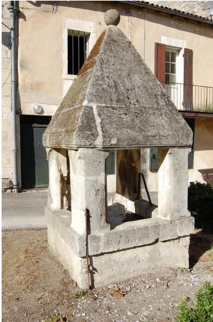
**Puits à toit pyramidal** surmonté d'un acrotere repose sur quatre jambages épais en pierre de taille. L'ensemble soigneusement appareillé est très esthétique.
