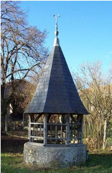
Superstructure avec un garde corps en bois ajouré surmontée d'une toiture en ardoises avec un épi de faitage en zinc. Le garde corps à un rôle de protection.
