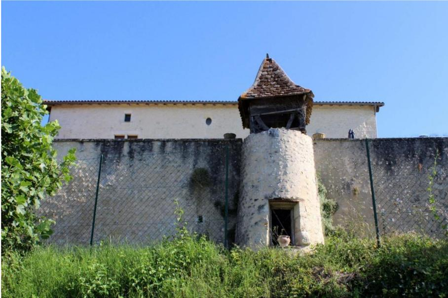
Chalais, puits à étage adossé au mur de clôture. La superstructure en bois est coiffée d'une toiture à quatre pans en tuiles écailles. L'eau peut-être puisée sur deux niveaux.
