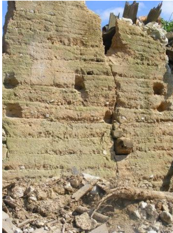
Un mur "de tape" (mur de terre massive) photographié avant sa destruction.
