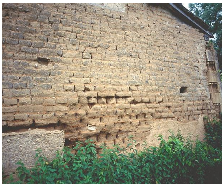
Un mur de "clairons", typique des constructions de terre crue du sud-charente
