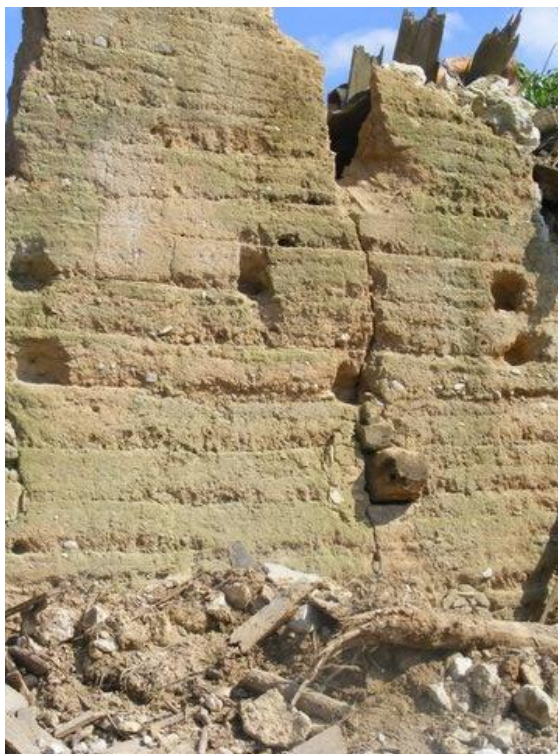
Un mur "de tape" (mur de terre massive) photographié avant sa destruction.
